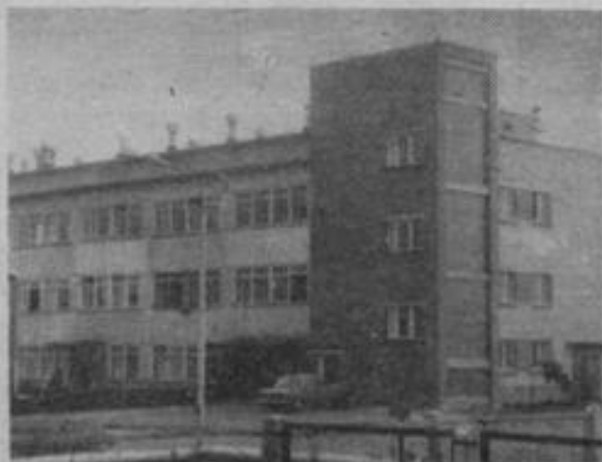
Eksperimentālās bioķīmiskās rūpnīcas adminis- tratīvais korpuss.
